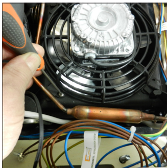
L1. Lösen Sie die Schraube auf das Schutzgitter des Lüfters
