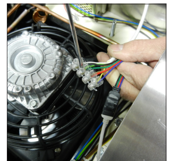
E4. Schliessen Sie die neuen Led Streifen an den Kabeln des Rezeptors wieder an, so wie die alten angeschlossen waren, nach Farbplan
