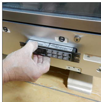
G2. Dévisser, enlever le thermoregulateur et déconnecter les câbles
