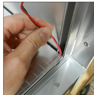
E3. Insérer les nouvelles bandes de LED à l'intérieur de profilés en aluminium et faire sortir les 4 câbles du trou
