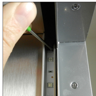
E2. Enlevez les bandes LED defectueuses des rails à l'aide d'un tournevis
