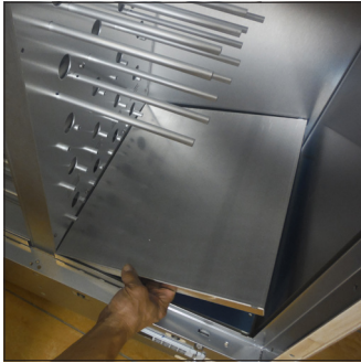
A3. Retirez les panneaux eu aluminium de couverture
