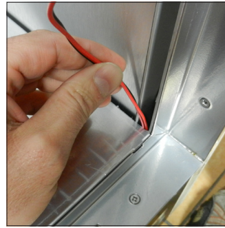
E7. Insérer les nouvelles bandes LED dans les profils en aluminium en sortant les 4 câbles du trou dans le bac
