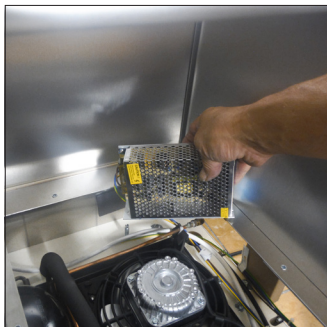
D1. Extraire l'alimentateur defectueux (fixé au paroi interieur de la cuve)
