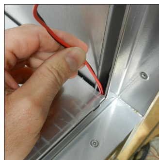
E3. Inserire le nuove strisce LED adesive all'interno dei profili in alluminio facendo passare i cavi nei 4 fori predisposti sulla vasca
