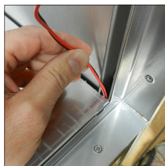
E7. Inserire le nuove strisce LED adesive all'interno dei profili in alluminio facendo passare i cavi nei 4 fori predisposti sulla vasca
