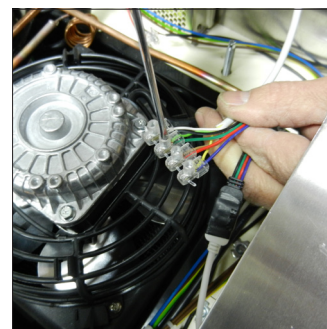
E4. Collegare i nuovi LED ai cavi del Controller come erano in precedenza rispettando i colori
