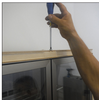
B1 . Svitare la vite / perno superiore posta sul top della vetrina
