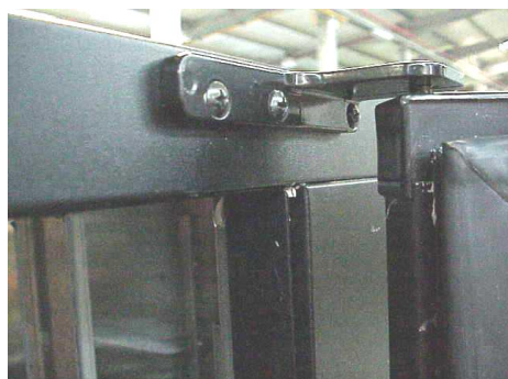
Fotografia 2 – Parafusos de fixação dos suportes superior e inferior da porta
