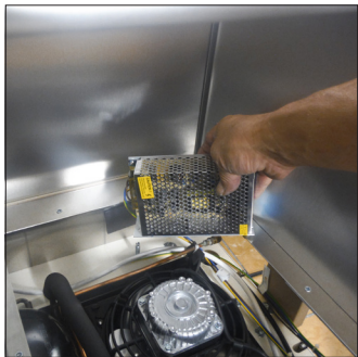
D1. Retirar la fuente de alimentación defectuosa (fijado en la pared interna del contenedor)
