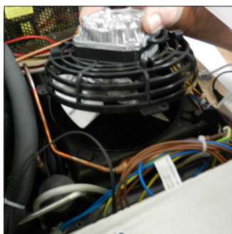
L2. Retirar el ventilador girando en sentido antihorario
