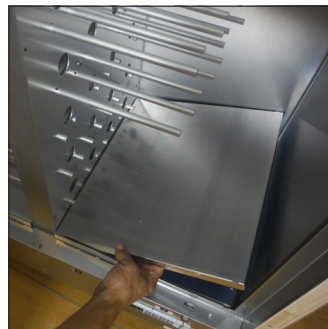
A3. Retirar los paneles en aluminio de acabado
