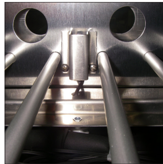
H3. Volver a colocar la sonda y la tapa de protecci n haciendo pasar el cable desde la abertura provista en el soporte inferior
