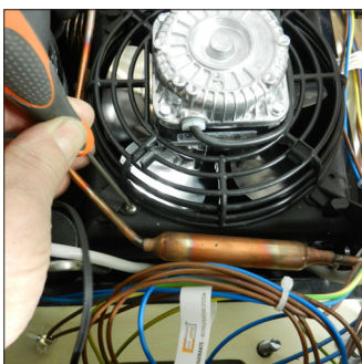
L1. Aflojar el tornillo de la rejilla de protecci n del ventilador
