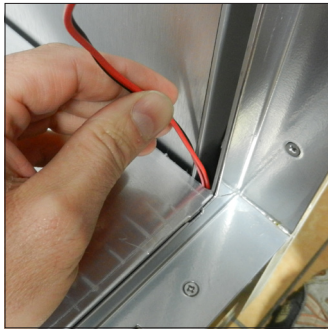
E3. Insertar las nuevas tiras de LED adhesiva en el interior de los perfiles de aluminio mediante el paso de los cables en las 4 aberturas en el contenedor
