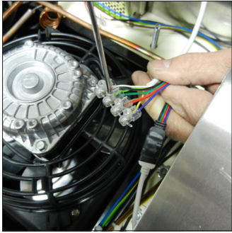
E4. Conectar los cables al nuevo receptor LED como estaban previamente para que coincida con el color
