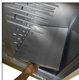
A3 . Verkleidung aus Aluminiumpanel entfernen.
