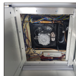
A5 . Compartiment du condenseur
