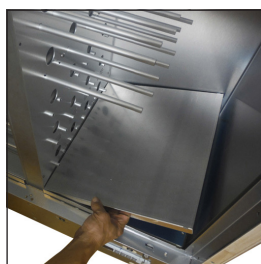
A3 . Retirez le panneau en aluminium de couverture
