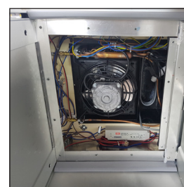
A5 . Compartiment du condenseur
