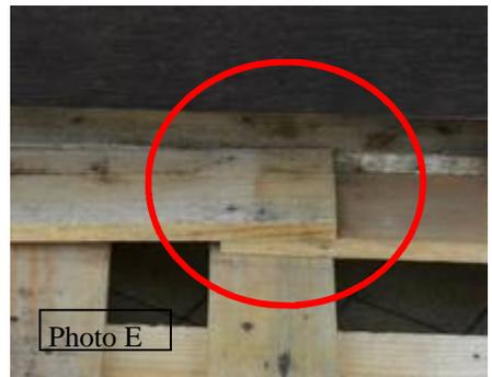
4. Glisser une seconde planche de déchargement (photo D) en face de la première. **TRES IMPORTANT** : Bien veiller à ce que la seconde se superpose avec la première (photo E).
