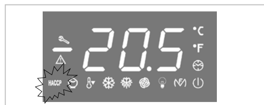
Ce LED indique un état d'alarme HACCP.
